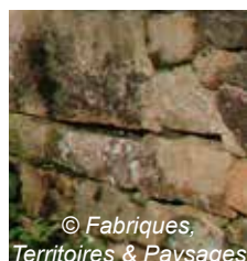
Mur en pierres sèches de granit
