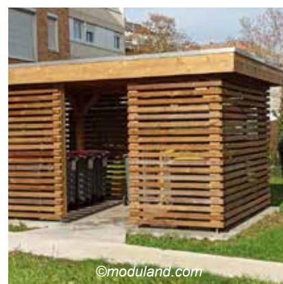
© Atelier du Rouget Nicolas Lamouroux Structure hybride faisant abris poubelle et pergola
