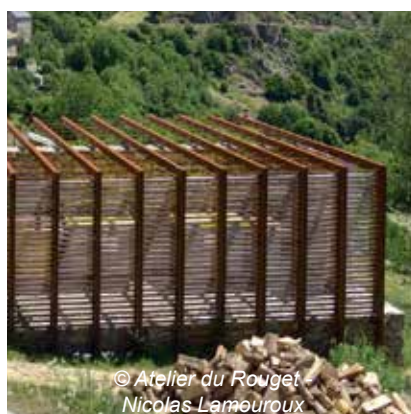
© moduland.com Structure intégrée pour la gestion des déchets en bardage bois
